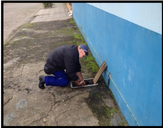
Figura 15 – Mudança no padrão dos hidrômetros. De interno para externo Fonte: Acervo próprio.
