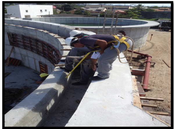
Figura 20 – Realização de atividades em altura (acima de 2m) – NR 35 Fonte: Acervo próprio.
