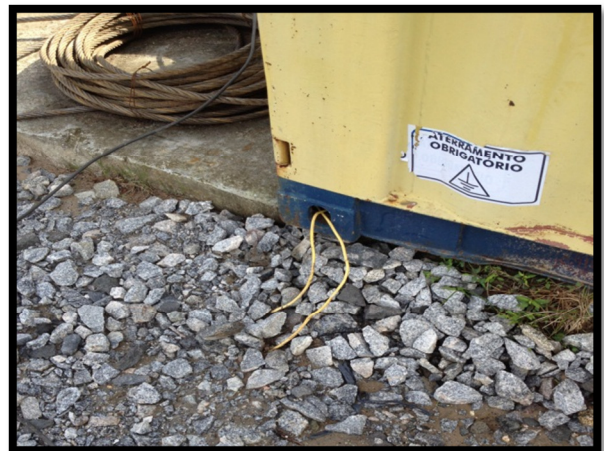
Figura 28 – Aterramento do container Fonte: Acervo próprio.
