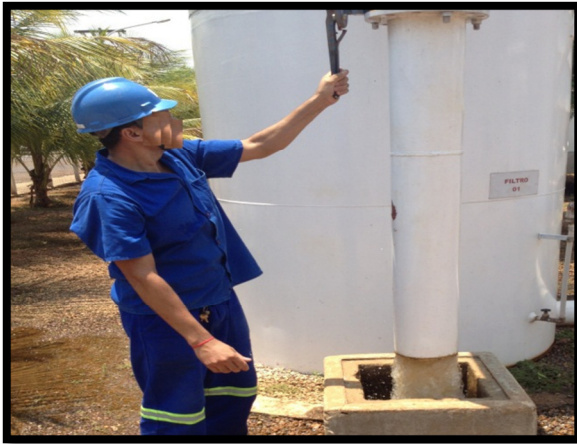
Figura 3 - Operação de ETA. Manuseio de válvulas. Fonte: Acervo próprio
