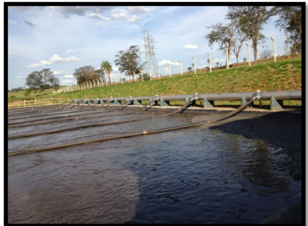
Figura 4 - Manutenção dos sopradores da lagoa de polimento. Fonte: Acervo próprio
