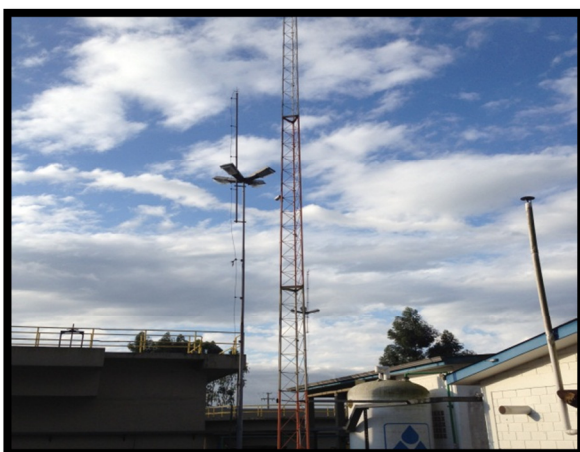
Figura 9 – Sistema de proteção contra descarga atmosférica - SPDA
