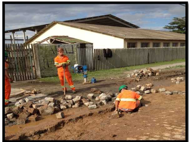
Figura 6 - Prestadores de serviços (terceiros) realizando fechamento de vala. Fonte: Acervo próprio
